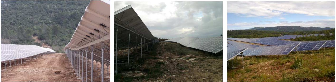
Figure 17 : Reprise de la végétation dans l'année qui suit le chantier
